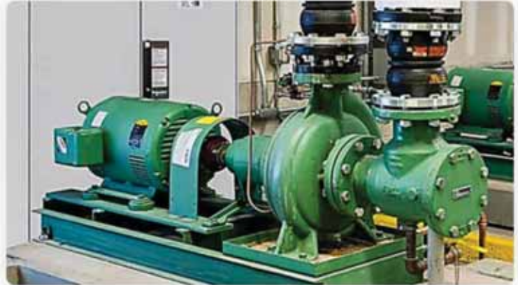
La desalineación es crítica en máquinas de acoplamiento directo (con acoplamiento)
